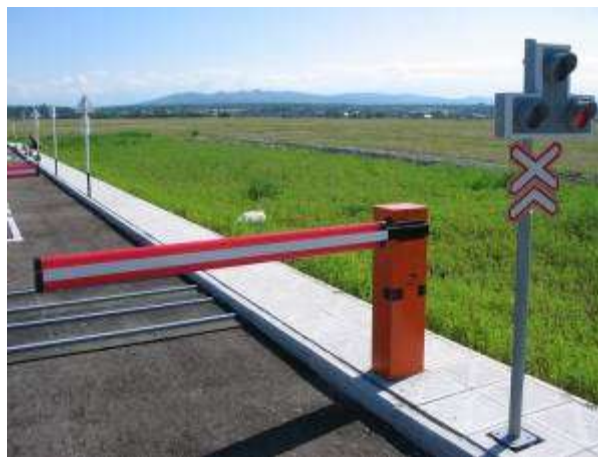
Рис. 6.3. Участок автоплощадки со шлагбаумом
